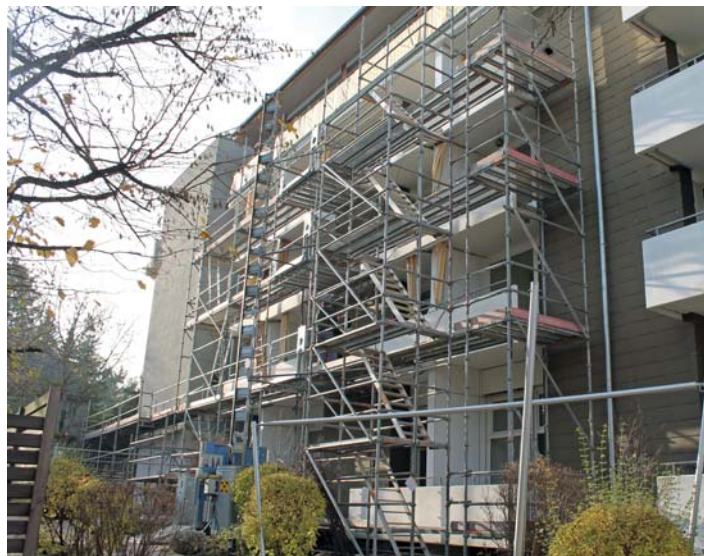
Eingerüstet: Auch von außen sind die Bauarbeiten sichtbar.
